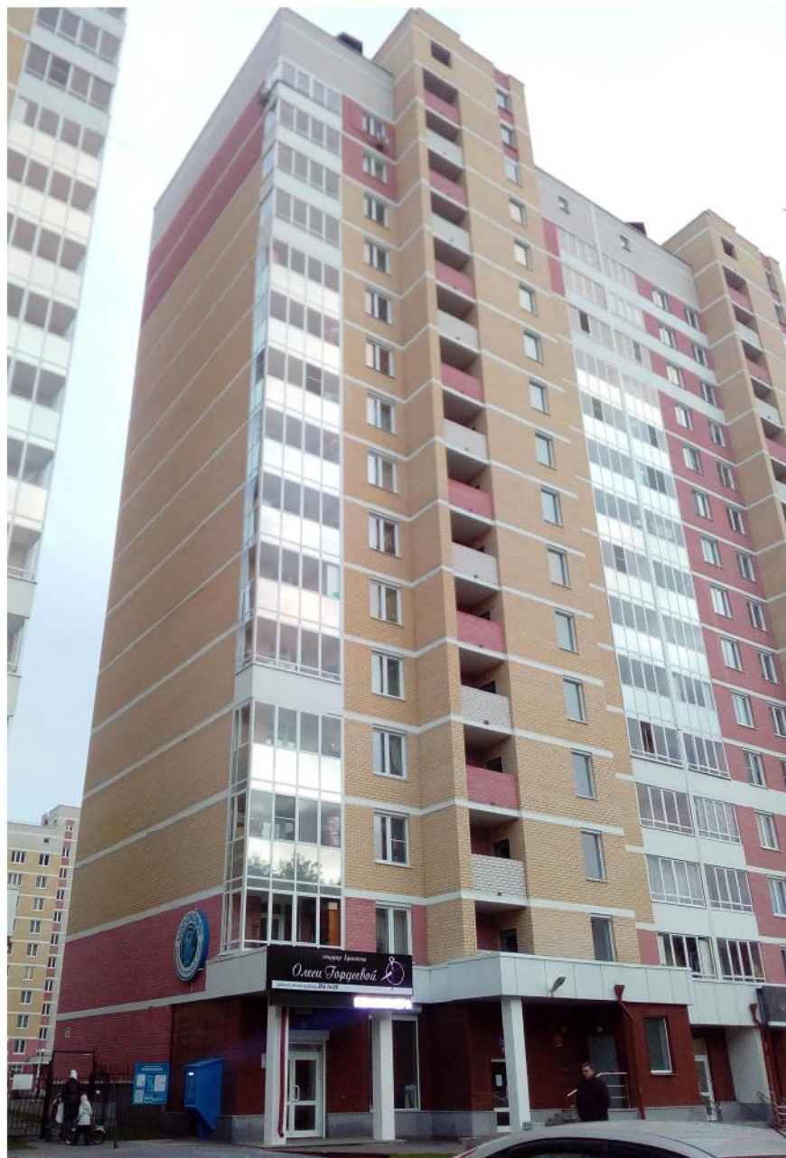
ТОРЦЕВОЙ ФАСАД СО СТОРОНЫ УЛ.АНАТОЛИЯ МЕХРЕНЦЕВА
